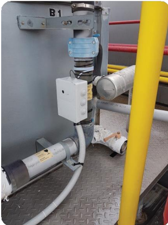
Πύργος Ψύξης Creta farm
