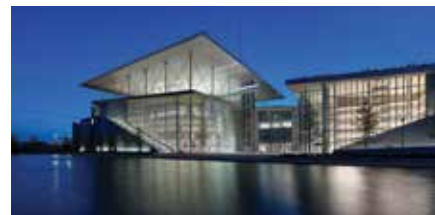
Κέντρο Πολιτισμού Ίδρυμα Σταύρος Νιάρχος (ΚΠΙΣΝ) 34 Ανεγκυστήρες
